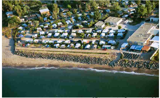
Ultime protection d'un camping à Vias
