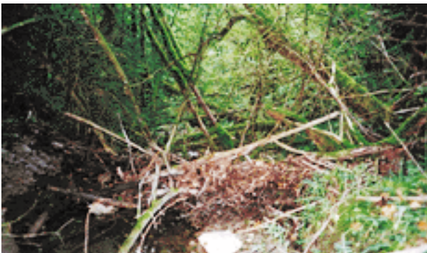
Dans les petits vallons très encaissés, le bois issu des berges ou des versants est peu mobile et lent à se décomposer. Il s'accumule donc dans le cours d'eau et rend celui-ci totalement impraticable.
