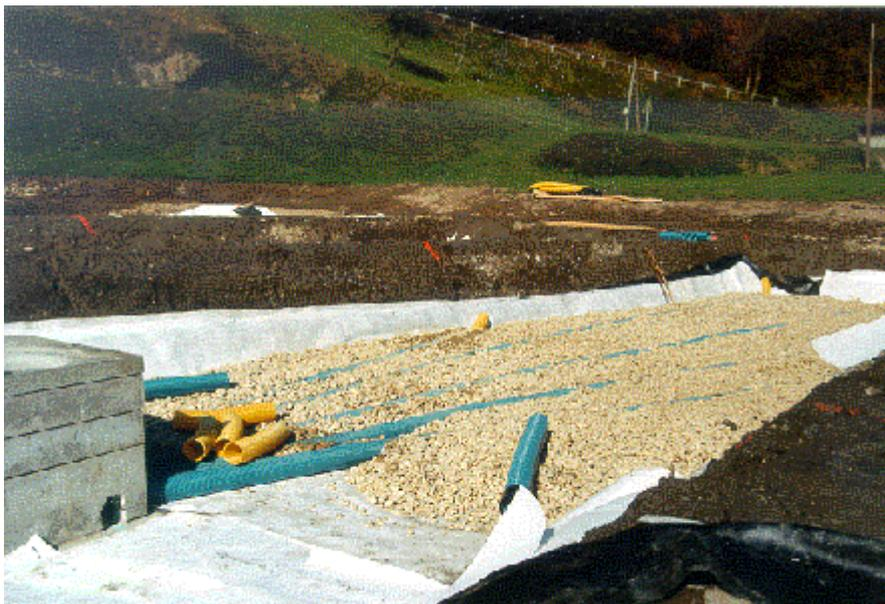
Photo 8 : Mise en place de la membrane, géotextile, tuyaux de drainage et couche de collecte (Photo M Cadic)
