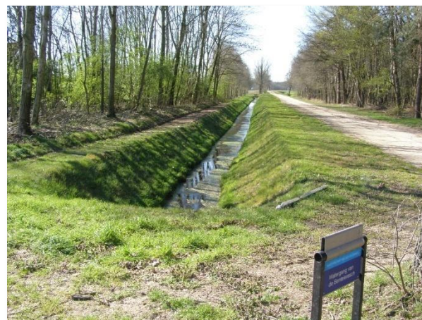
Watringue. Ce terme désigne un réseau de fossés et d'ouvrages de drainage à vocation de dessèchement dans les polders du Nord de la France. Photo : Domaine public.
