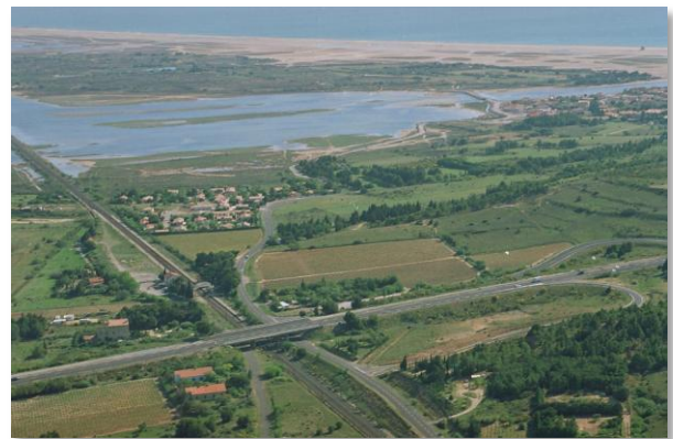
Infrastructures routières en bordure d'une lagune. Photo : FONBONNE.
